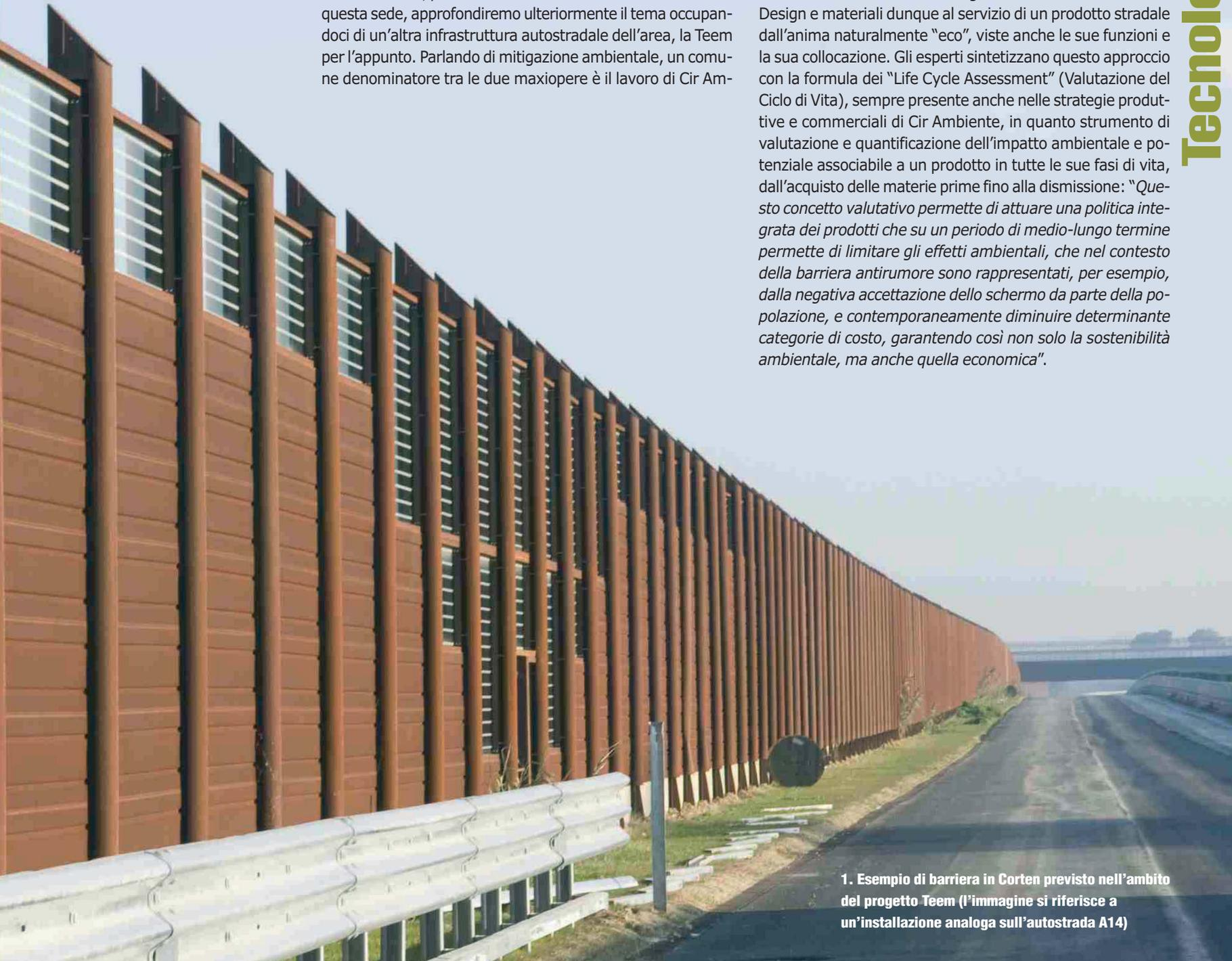
**1. Esempio di barriera in Corten previsto nell'ambito del progetto Teem (l'immagine si riferisce a un'installazione analoga sull'autostrada A14)**
