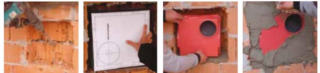
Una volta posizionato il TORNADO nello scasso precedentemente realizzato, fissarlo con materiale cementizio.
