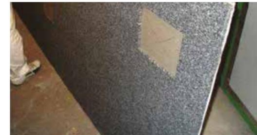
Il fissaggio del sistema a parete dovrà essere effettuato a mezzo di tasselli in plastica e/o a colla, avendo cura di accostare i pannelli l'uno all'altro. Realizzare il minor numero possibile di punti di incollaggio, per evitare ponti acustici. Eventualmente applicare una seconda lastra sfalsata rispetto alla precedente e fissata a mezzo viti da cartongesso alla precedente per
