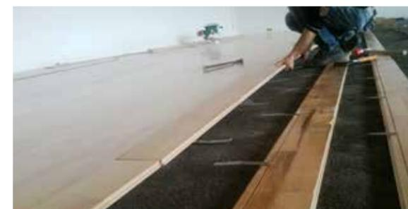
Posa sotto pavimento flottante ( sistema a secco ).
