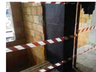
Cirmix flex è un prodotto duttile altamente prestazionale adatto a risolvere vari problemi di isolamento acustico : ad esempio l'eliminazione del ponte acustico PILASTRO / PARETE o l'assorbimento del rumore che passa attraverso al cassonetto delle tapparelle.
