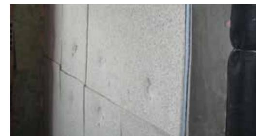
Evitare la formazione di eventuali ponti acustici edificando la muratura o posando i placcaggi in cartongesso su un supporto orizzontale resiliente tipo CIRFONIC PAV 2000 STRISCIE, costituito da un agglomerato poliuretano ad alta densità in grado di creare discontinuità strutturale.
