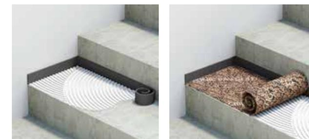
È sufficiente applicare a colla il manto anticalpestio CIRFONIC PAV GOLD o CIRFONIC PAV 2000 direttamente sulla superficie delle rampe delle scale
