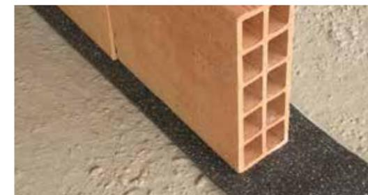
Evitare la formazione di eventuali ponti acustici edificando la muratura o posando i placcaggi in cartongesso su un supporto orizzontale resiliente tipo CIRFONIC PAV 2000, costituito da un agglomerato poliuretano ad alta densità in grado di creare discontinuità strutturale.
