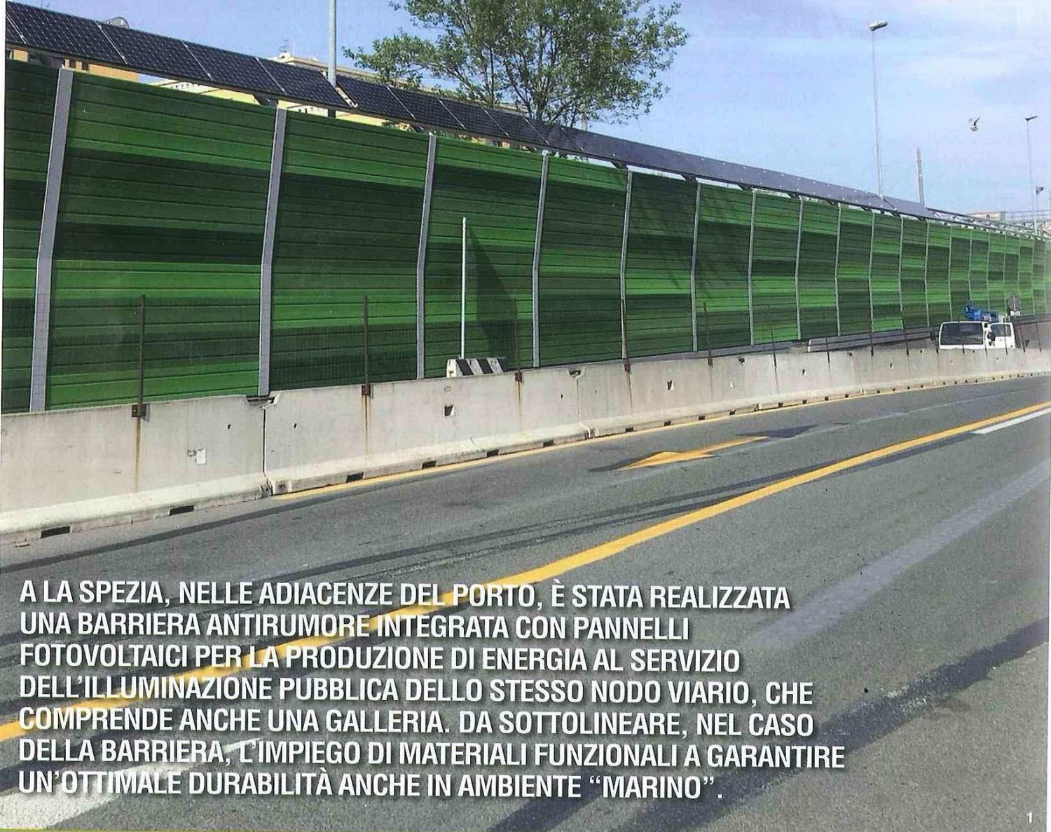
A LA SPEZIA, NELLE ADIACENZE DEL PORTO, È STATA REALIZZATA UNA BARRIERA ANTIRUMORE INTEGRATA CON PANNELLI FOTOVOLTAICI PER LA PRODUZIONE DI ENERGIA AL SERVIZIO DELL'ILLUMINAZIONE PUBBLICA DELLO STESSO NODO VIARIO, CHE COMPRENDE ANCHE UNA GALLERIA. DA SOTTOLINEARE, NEL CASO DELLA BARRIERA, L'IMPIEGO DI MATERIALI FUNZIONALI A GARANTIRE UN'OTTIMALE DURABILITÀ ANCHE IN AMBIENTE "MARINO".
